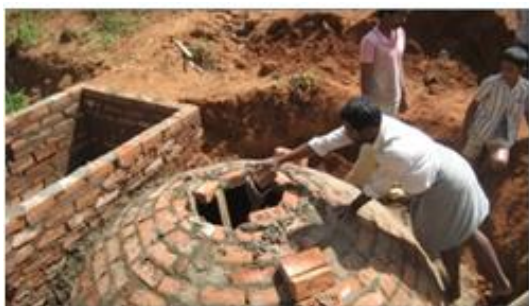
Photographie 14-a : Construction d'un réservoir à biogaz en Inde. Valorisation des déchets animaux pour la production d'énergie.
