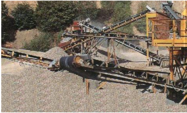
c : Exploitation de carrière de calcaire : la roche du gisement de calcaire est concassée en petits morceaux appelés granulats.
