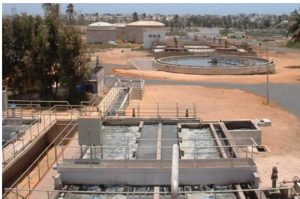
Document 10: Station d'épuration de Cambéréne.
