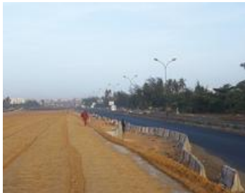
Document 1 : Travaux de l'autoroute à péage Dakar – Diamniadio.
