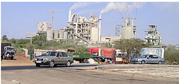
e : Usine SOCOCIM cimenterie de Rufisque. Le principe de la fabrication du ciment est le suivant: mélange de calcaires (80%) et argiles (20%) broyés, homogénéisés, portés à haute température (1450°C) dans un four. Le produit appelé (Clinker) est mélangé à d'autres produits, broyé à nouveau puis refroidit rapidement.
