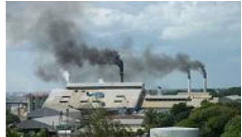
Document 5 : Rejet de gaz industriel.
