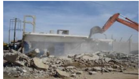
Document 3 : Démolition d'habitations sur le tracé de l'autoroute à péage Dakar – Diamniadio.
